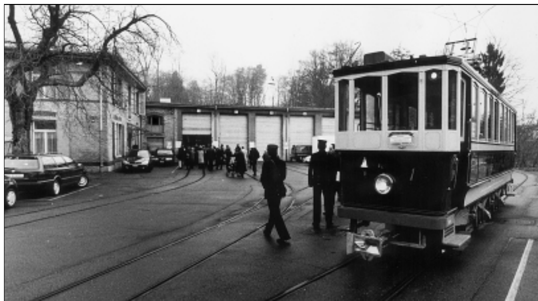
Das Tramdepot Burgwies mit einem Oldtimer-Tram im Vordergrund. Hier soll dereinst das Tram-Museum untergebracht werden. (Bild Hofer)
