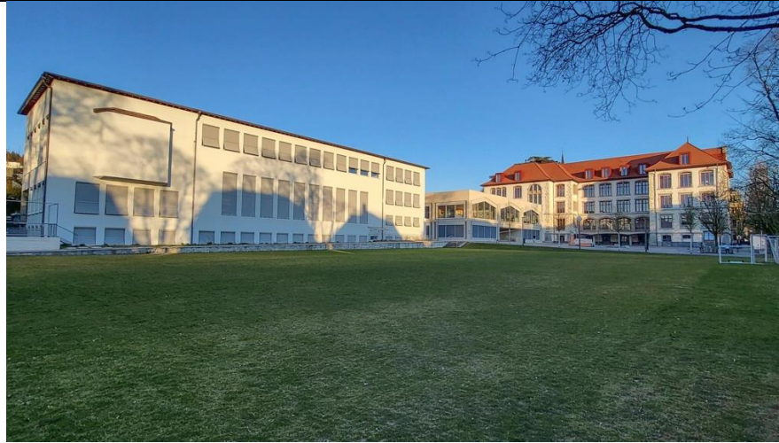
Abb.14.3 Der Neubau zwischen zwei Altbauten. (Foto: Peter Hammann)
