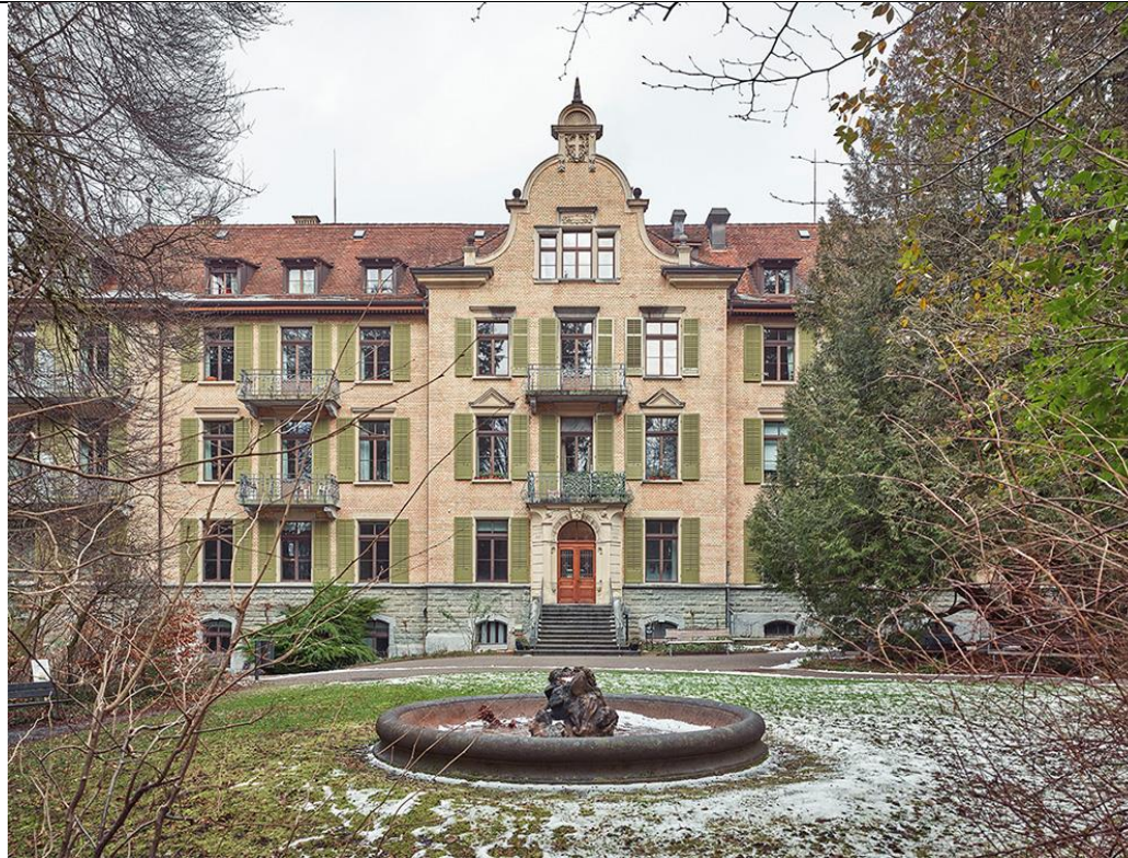
Abb. 15.1 Der Eingang des Gesundheitszentrums für das Alter Klus Park auf der Parkseite. (Foto: raumfalter Architekten)
