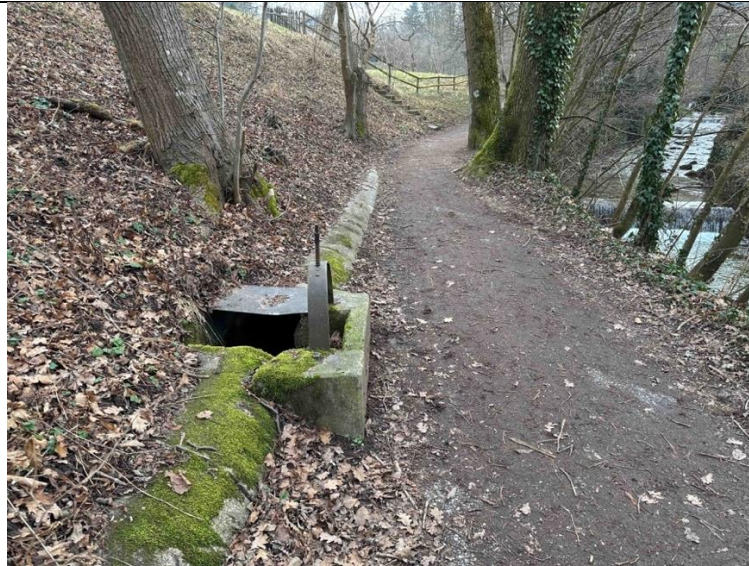
Abb. 5.5 Oberwasserleitung zur Mühle / Schreinerei Burgwies mit Leerlaufschütze. (Fotos Herbert Frei)
