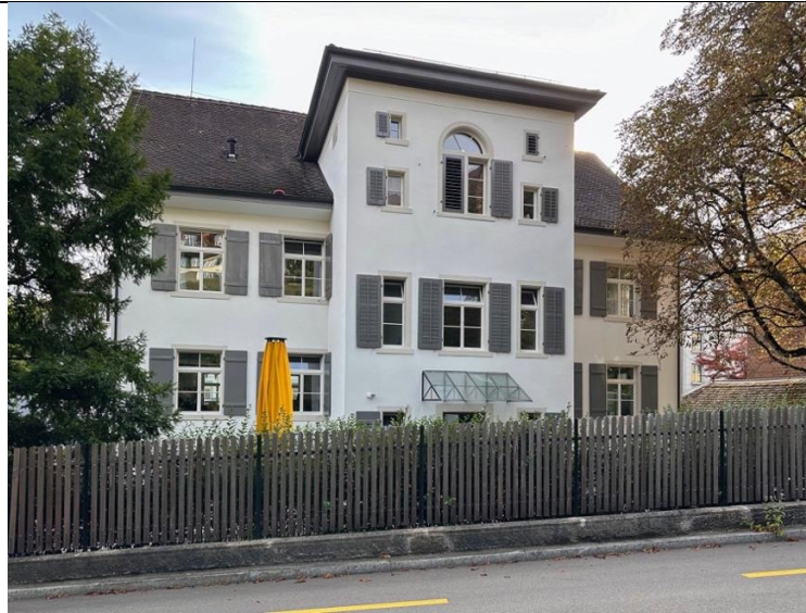
Abb. 10.1 Schulhaus, Rückseite zur Sempacherstrasse, Mittelrisalit mit Treppenhaus. (Foto Herbert Frei)
