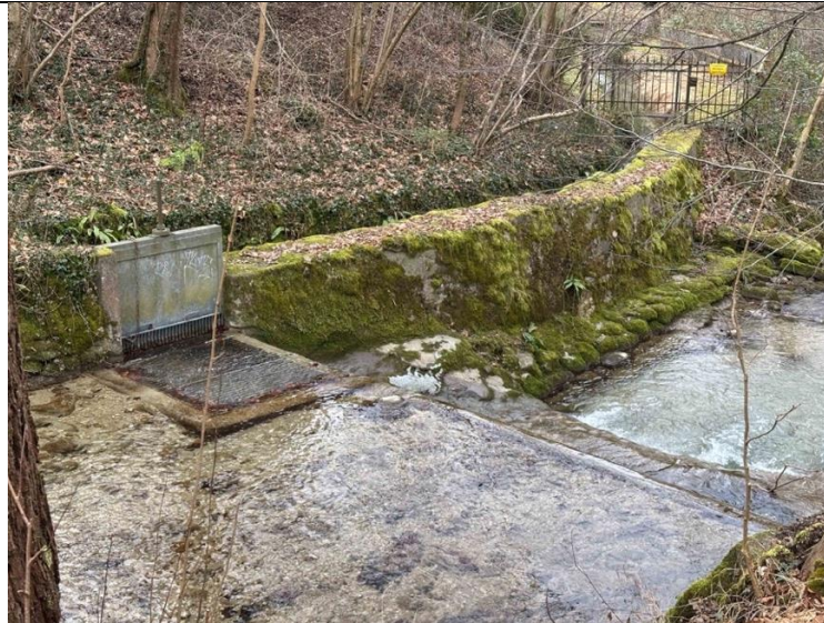
Abb. 5.1 Wehr und Oberwasserkanal vom Wehrenbach zum Mühleweiher Burgwies
