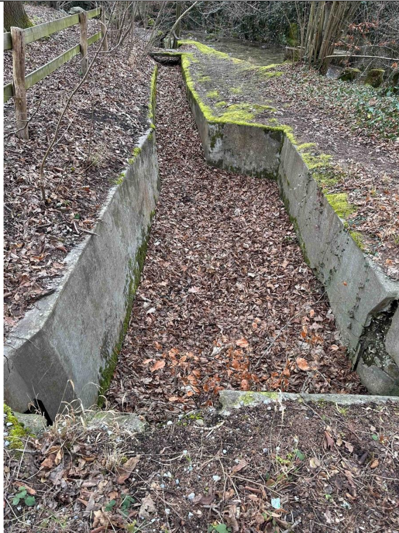
Abb. 5.4 Offener Kanal zur Mühle Burgwies mit Schlammsammler
