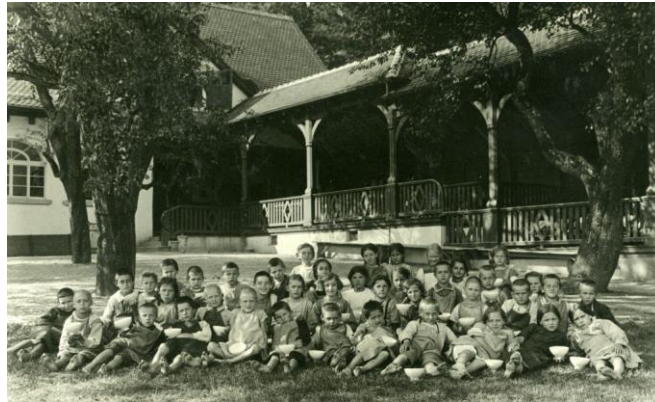
Abb. 2.1 und 2.2 Waldschulhaus, mit Liegehalle, 1950. Fotos: BAZ.
