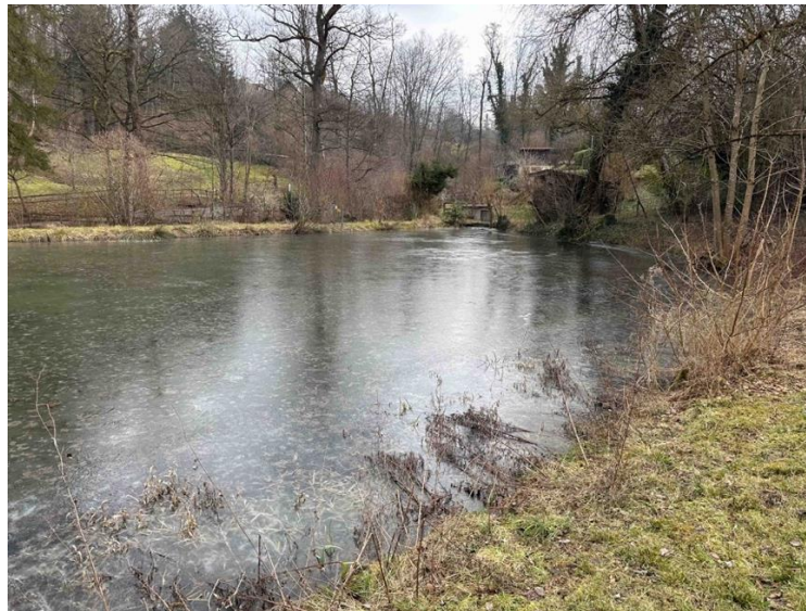
Abb. 5.2 Mühleweiher Burgwies, am Einlass liegt das Kleinkraftwerk.
